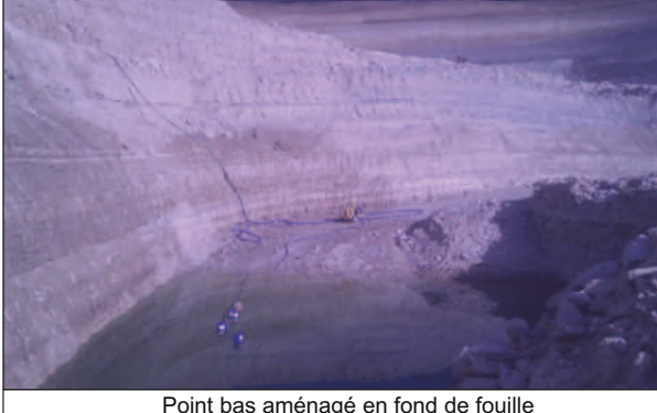
Front des 2 ème et 3 ème masses noyé en hiver zoom sur la pompe de relevage
