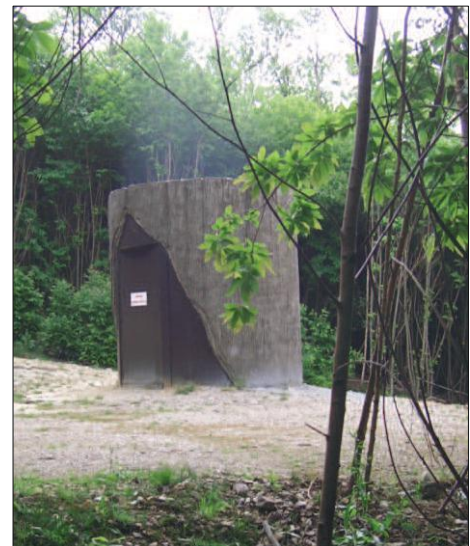
Puits d'aérage de la carrière souterraine de Montmorency
